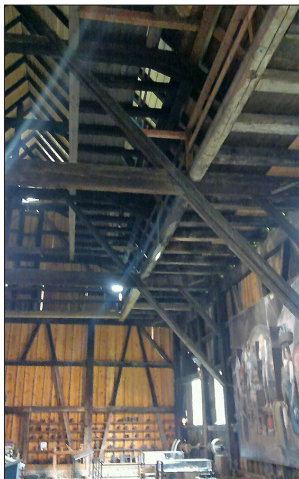
8. ábra: Az üvegsűr feltételezett tetőszerkezete egy németországi példa alapján (Fotó: Borsi-Lakatos László)
